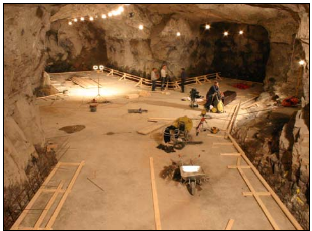
Nytt datacenter "Pionen" under uppbyggnad. Här kommer att finnas plats för 8000 servrar och här byggs en av Stockholms stora nätknutpunkter.
