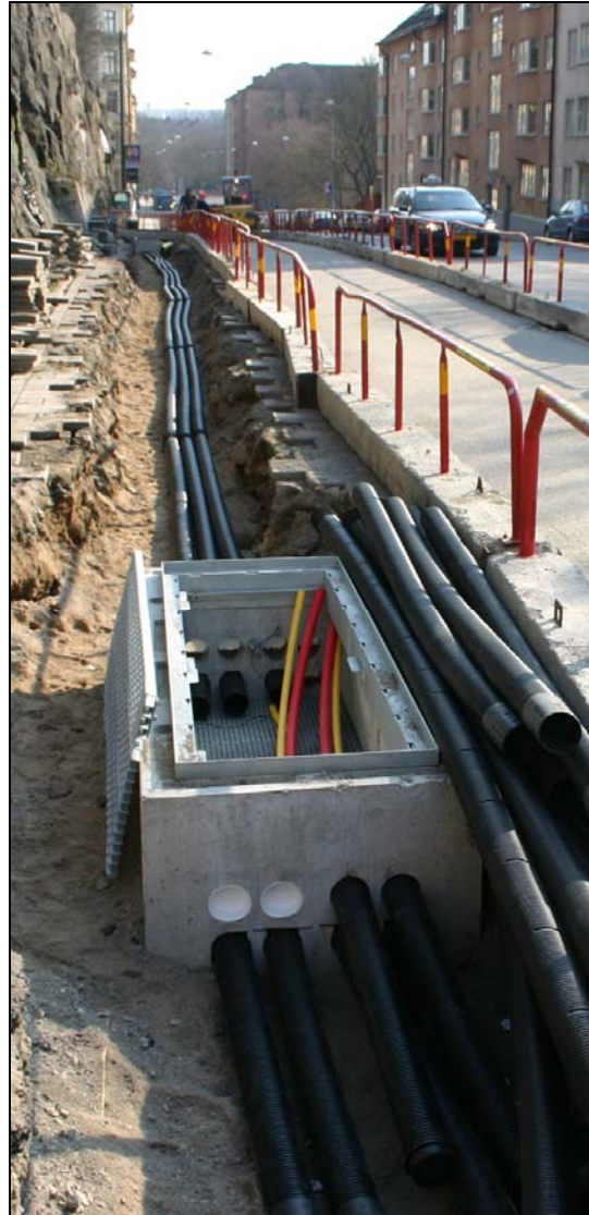
El och fiberkabel grävs ner för nya serverhallen "Pionen", Stockholm.
