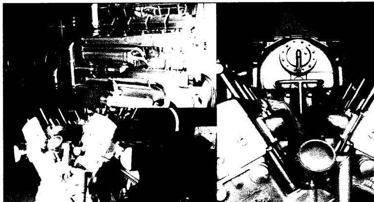
Dieselmotor för strömbakup
